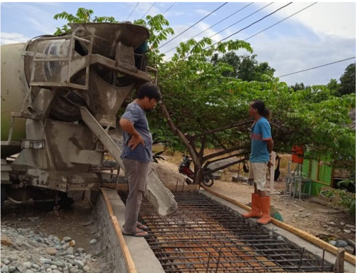
Pembangunan Plat Duiker Desa Mario, Kab. Luwu Utara
